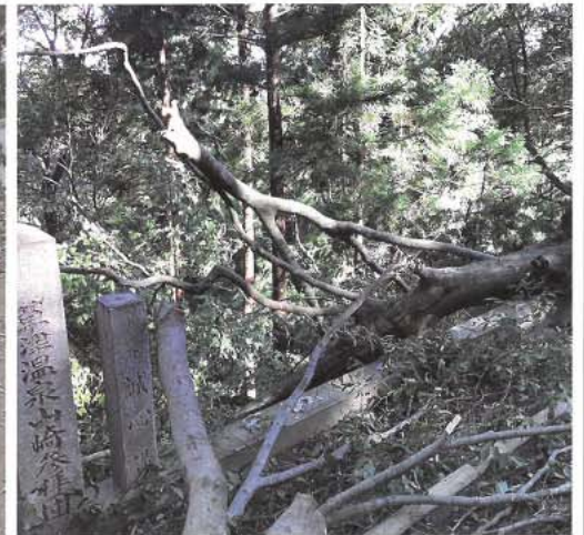
倒木により破壊された玉垣
