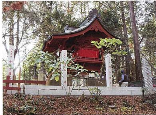
玉垣が建てられている工事の様子
